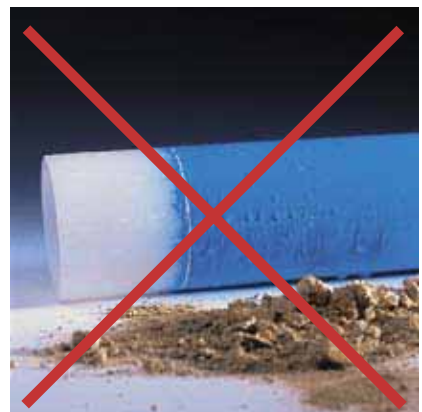
Рис. 61 Свариваемые поверхности не должны быть мокрыми или загрязненными
