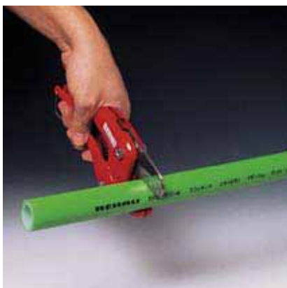
Рис. 7 1. Отрезать трубу по размеру под прямым углом
