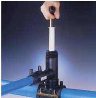
Рис. 49 10. После завершения вырезания отверстия в трубопроводе вывернуть фрезу, вращая ее до упора против часовой стрелки
