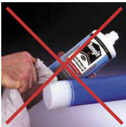
Рис. 62 Нельзя применять для очистки и протирки использованную ветошь. Используйте только негигроскопичные специальные салфетки
