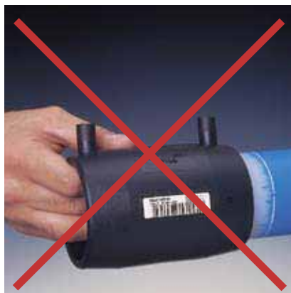
Рис. 60 ЭСМ-муфту нельзя трогать изнутри руками
